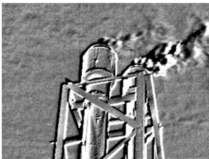
Figura 9.3: Rilievo mediante termocamera dei vent in un impianto di riduzione della pressione
