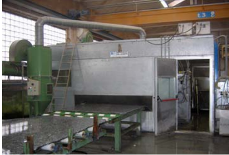
Fig.2: Bocciardatrice cabinata e abbattimento con getti nebulizzatori d'acqua
