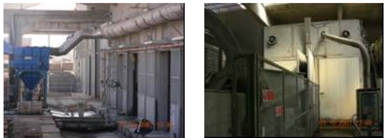
Fig.2: Taglio blocchi con telai multilame in box con aspirazione
