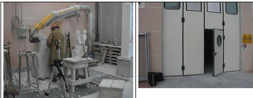
Fig.5-6: Cappe aspiranti orientabili (3) e griglia a pavimento (4)
