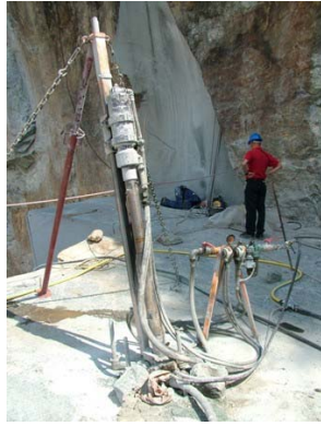
Fig.2: Perforatrice meccanica con spurgo d'acqua
