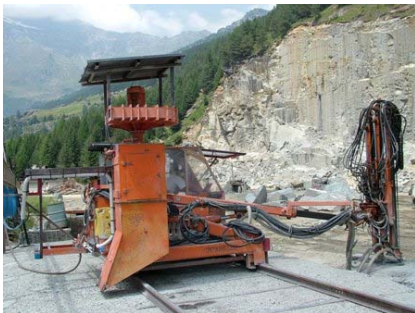
Fig.4: Perforatrice meccanica cabinata con spurgo d'acqua
