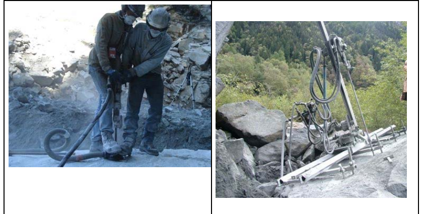
Fig.1: Perforazione con perforatrici manuali e meccaniche
