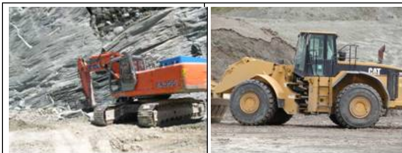
Fig.1: Movimentazione meccanica con automezzi di sollevamento cingolati e gommati
