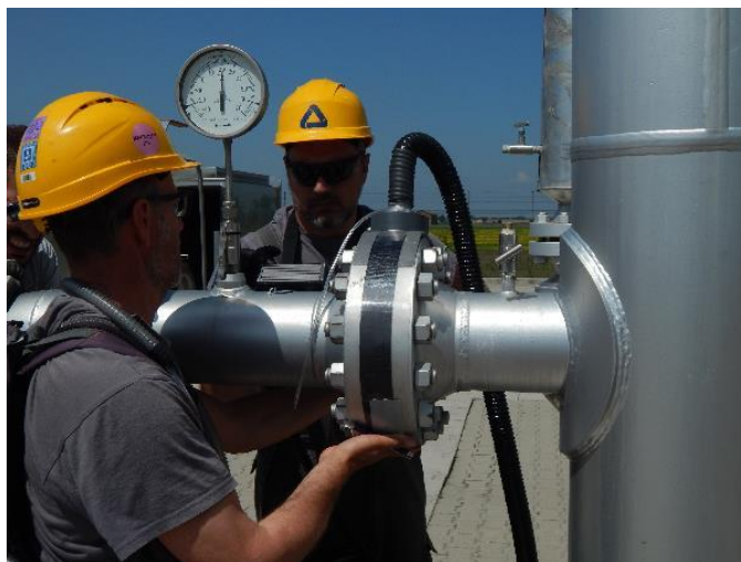
Figura 9.2: Rilievo mediante strumentazione Hi-Flow™ Sampler
