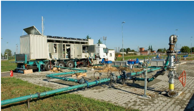
Figura 9.5: Intervento di ricompressione con compressori mobili sulla rete di trasporto
