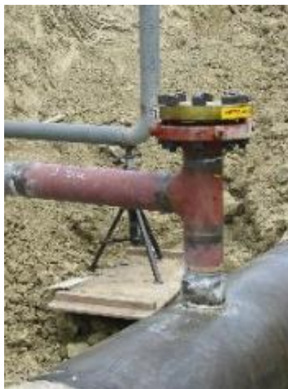
Figura 9.6: Realizzazione di stacco da condotta in esercizio mediante tapping-machine
